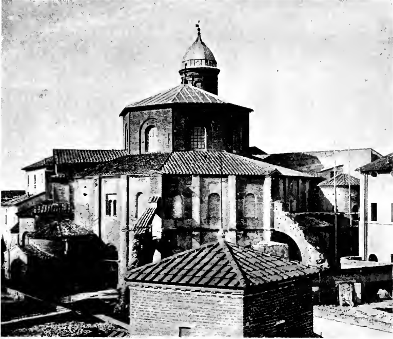
Fig. 86 - Veduta esterna della basilica di San Vitale a Ravenna, durante i restauri in corso (a. 526-547)
